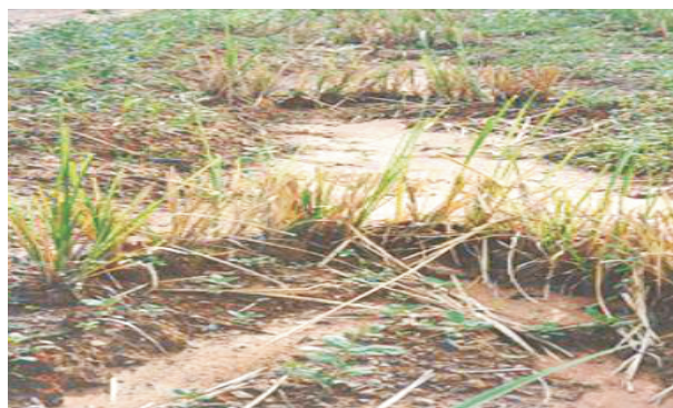
图13: 因径流而引起的侵蚀冲沟,在冲沟方向垂直栽植香根草绿篱,就可使冲沟稳定下来,阻止泥沙入库。
